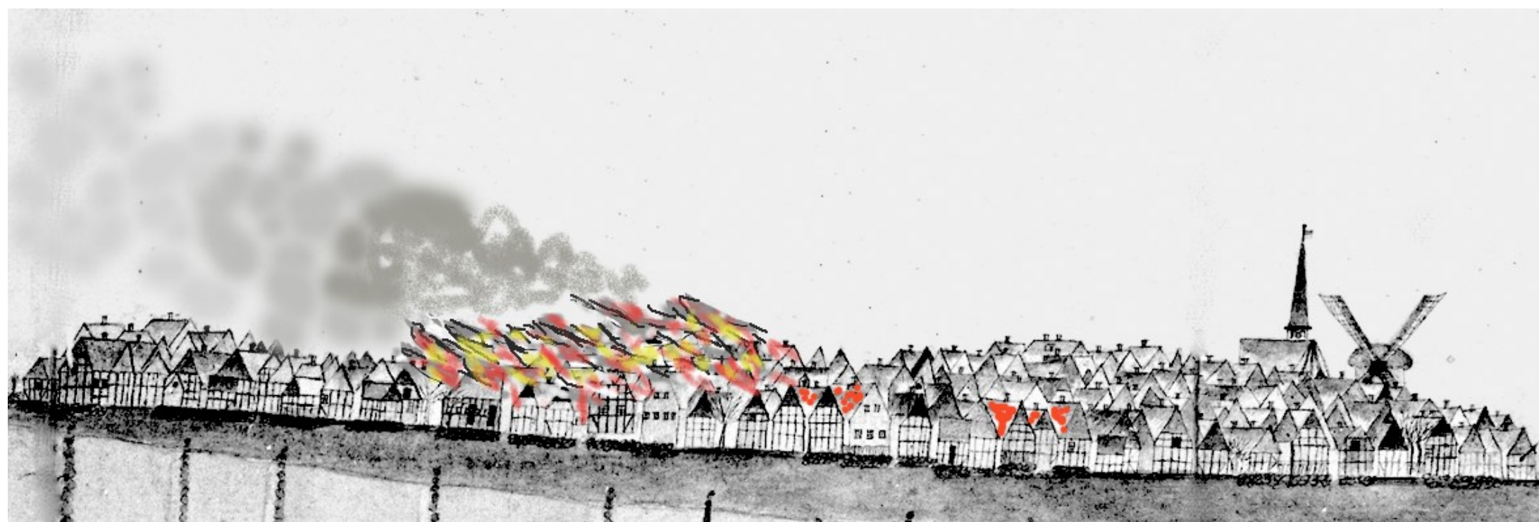
Bybranden oplyste nattehimmelen så det kunne ses på lang afstand.
