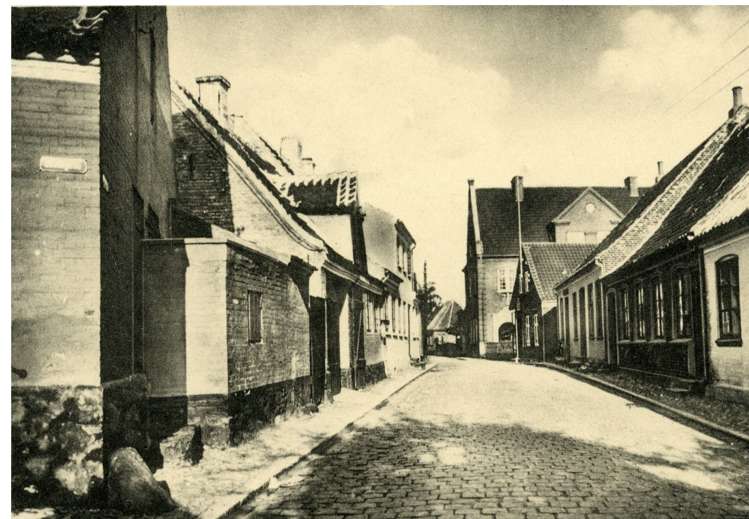
Skolebygningen på hjørnet af Tværgade og Skolegade.
