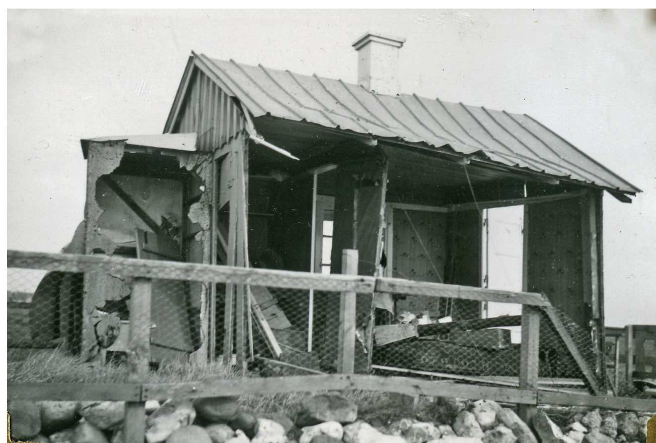
Et af de ødelagte badehuse efter minesprængningen.
