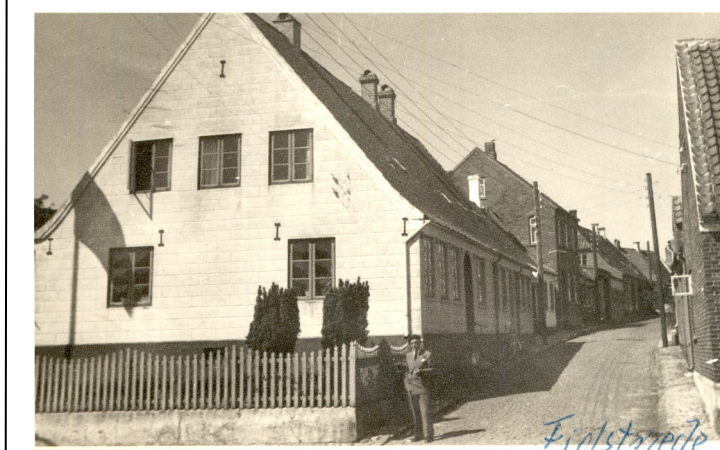
Postkontoret ligger til højre for indgangsdøren ved trappen.
